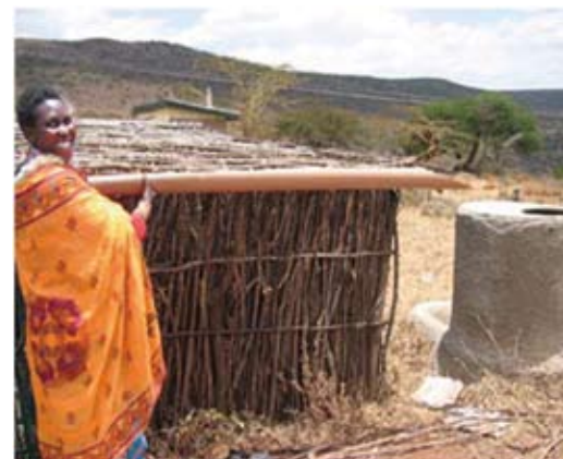
Un système de RWH à faible coût à partir d'un toit traditionnel. Photo: IRHA-H 2 O
