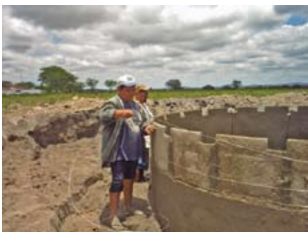
Edilene construisant un réservoir à Sítio Minador
